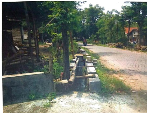
SALURAN AIR DUSUN WATES
